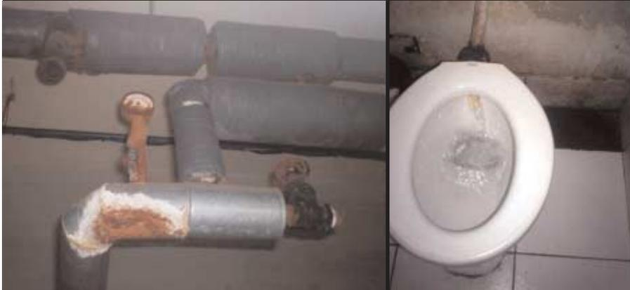
Los beneficios usualmente están en los detalles. Foto izquierda: una trampa de vapor y aislamiento inadecuado. Foto derecha: el abundante uso de agua en un inodoro defectuoso.
